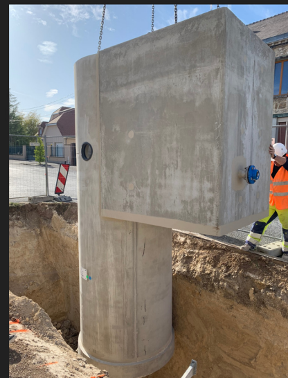
Chambre à vannes accolée
