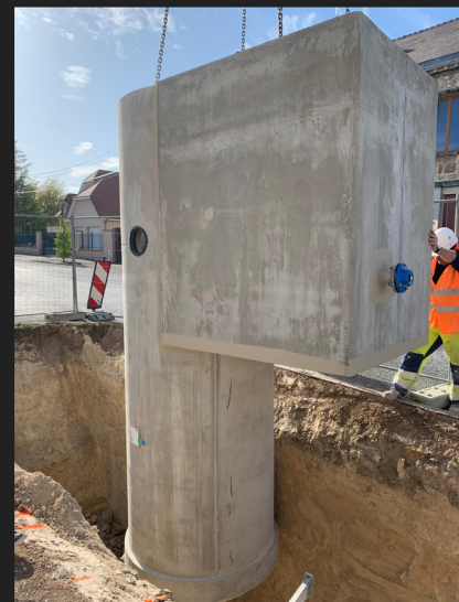
Chambre à vannes accolée
