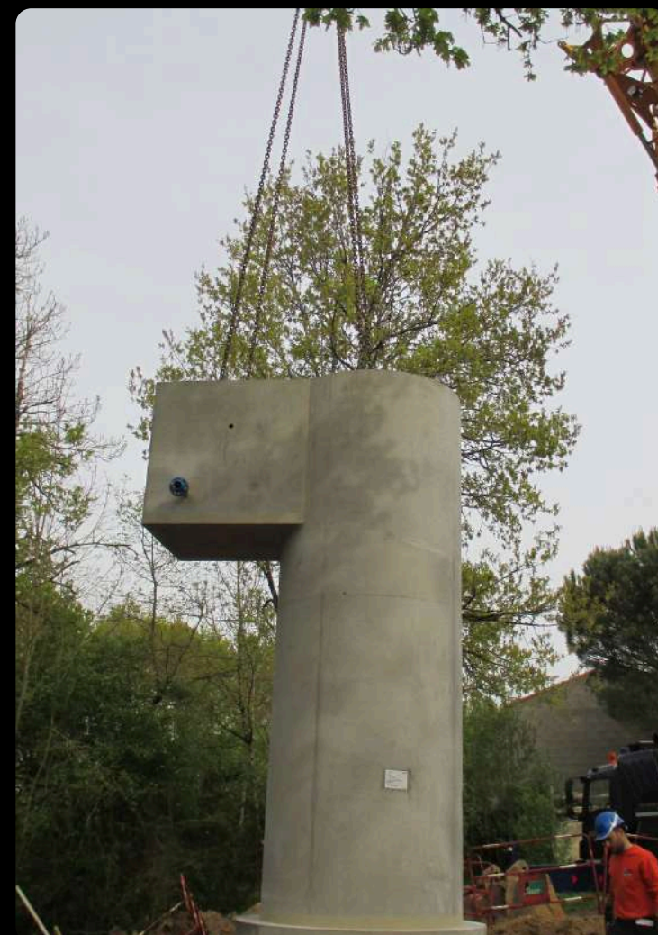
Chambre à vannes accolée
