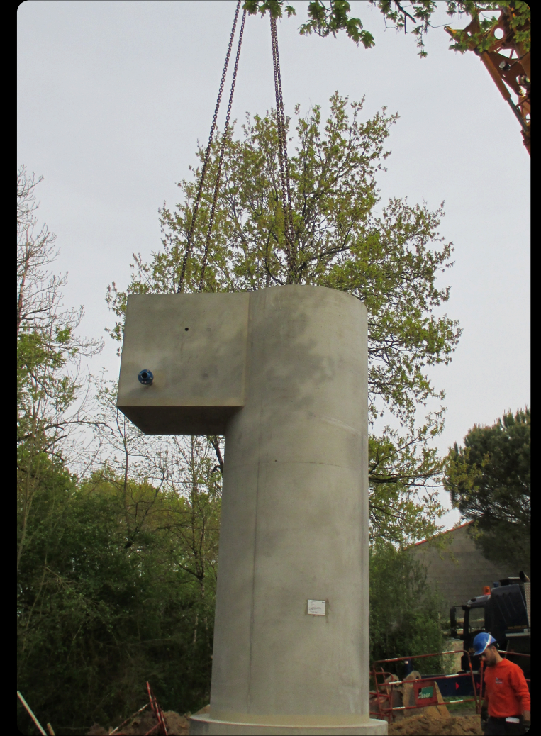
Chambre à vannes accolée
