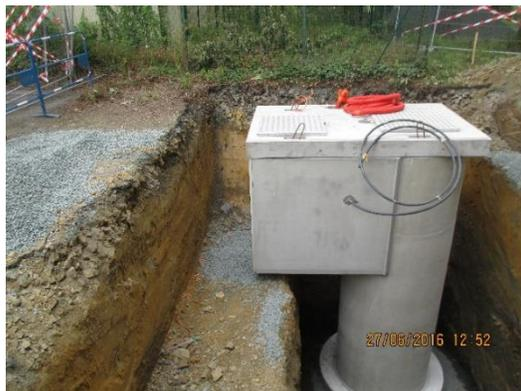
Nous préconisons la réalisation d'un lit de pose en fond de fouille en gravillon 6/10 d'une épaisseur de 20cm (à vérifier selon la nature du terrain du site).
