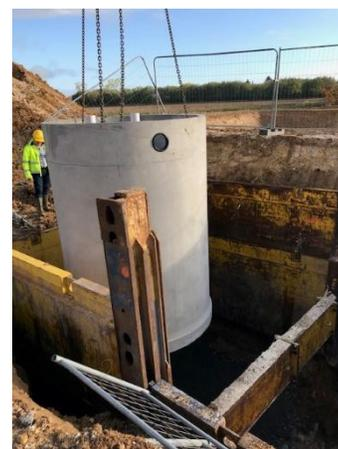
Nous préconisons la réalisation d'un lit de pose en fond de fouille en gravillon 6/10 d'une épaisseur de 20cm (à vérifier selon la nature du site).
